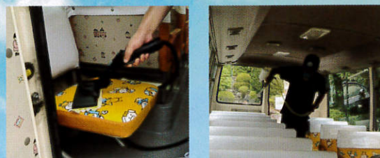
幼稚園バス 施工 塗布面スチーム清掃 (左) 光触媒『イオニア ミストPRO』 散布 (右) の様子
